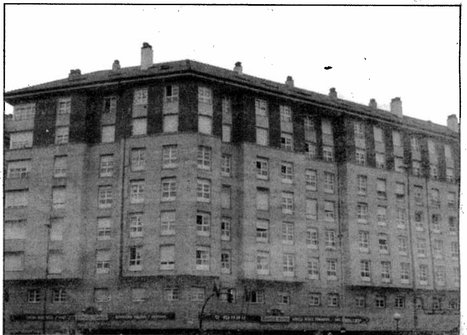
Fachada principal de la Residencia Espiritu Santo en la calle Poeta Alfonso Camín de Gijón.
